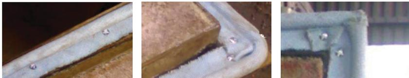
Pas de détérioration de la bande lors de la mise en place, en cas de perçage de celle-ci lors de l'installation.
